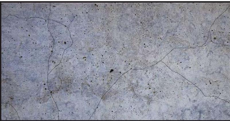
Las temperaturas de verano traen sus propios problemas específicos al echar concreto fresco. Dos problemas comunes son el agrietamiento por contracción plástica y agrietamiento por contracción de secado.
